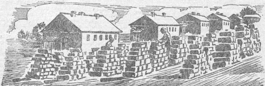
По СССР, наряду со стандартным строительством в Донбассе начали широко применять постройку домов из подсобного местного материала. Таким материалом является саман. Саман предварительно подвергается испытаниям. Результаты показывают, что он может быть использован очень широко. На снимке: формовка самана в Кадиевском р-не (Донбасс)
